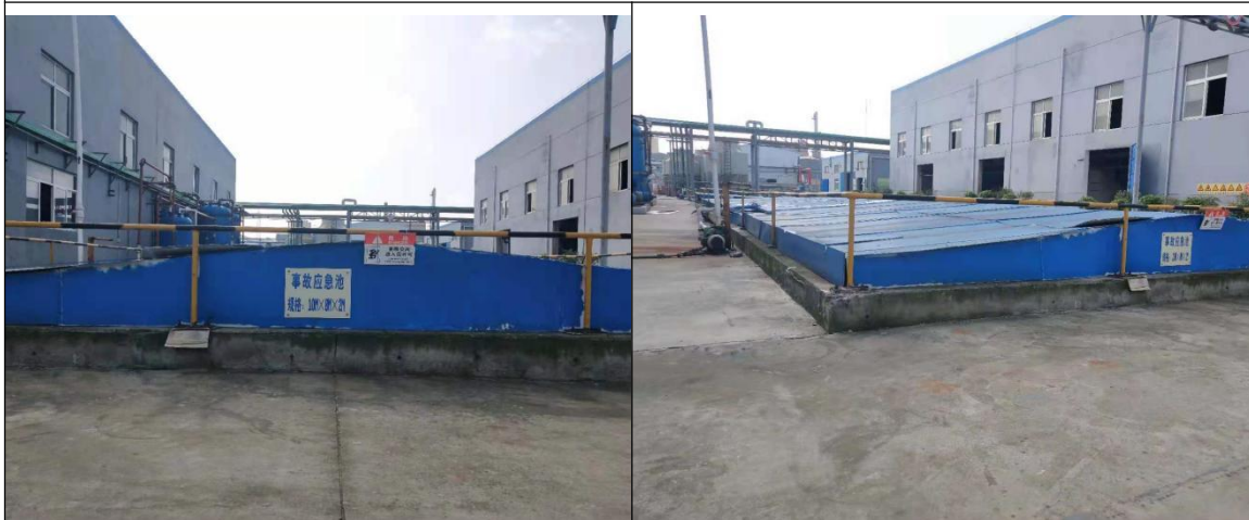
事故应急池：为地下实池体，地面均已硬化，无破损。
