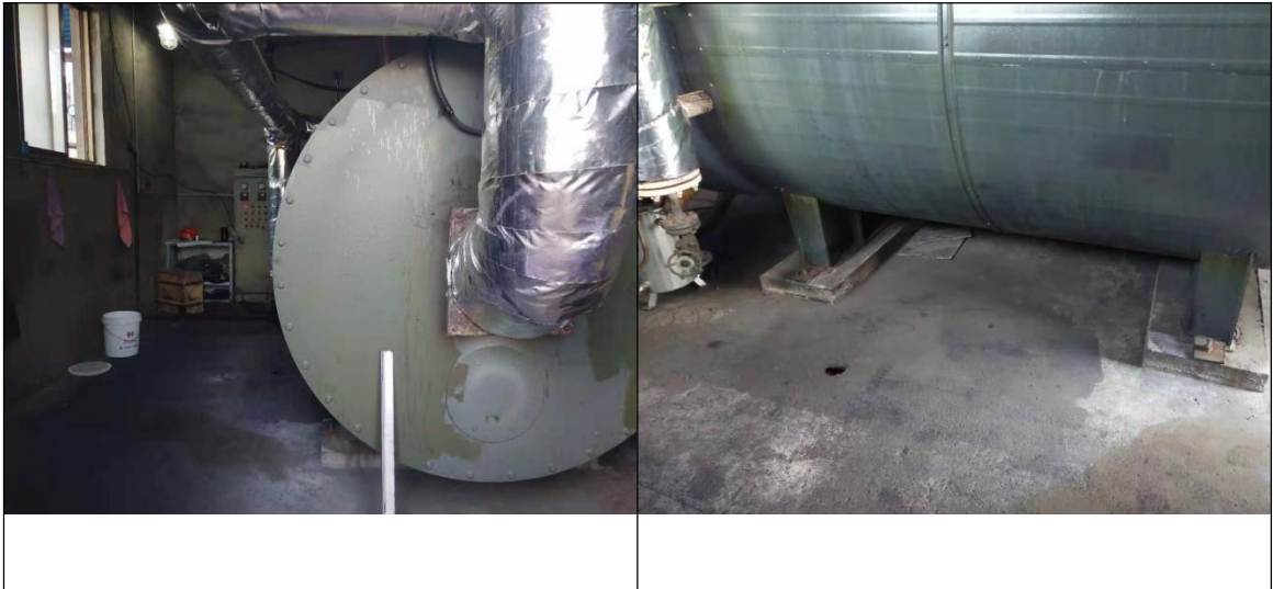
锅炉房：地面均已硬化，无明显裂痕。
