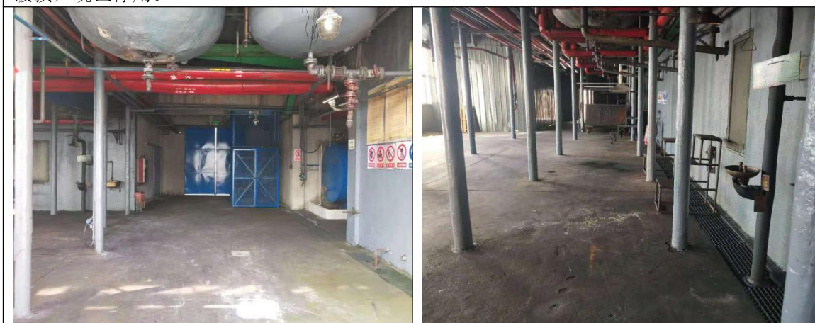
永固紫合成车间：完成烷基化，硝化，加氢，缩合闭环反应生成粗品永固紫，车间地面均已硬化，无明显裂缝。
